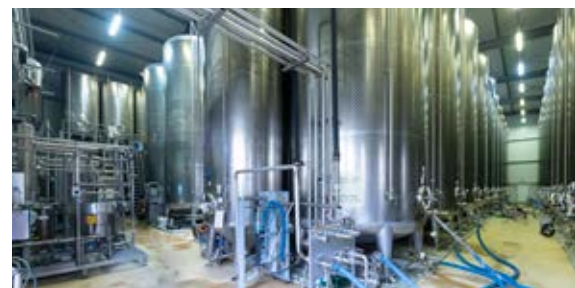
Das Tanklager der Kelterei. Von hier aus wird der Saft in Flaschen abgefüllt.
